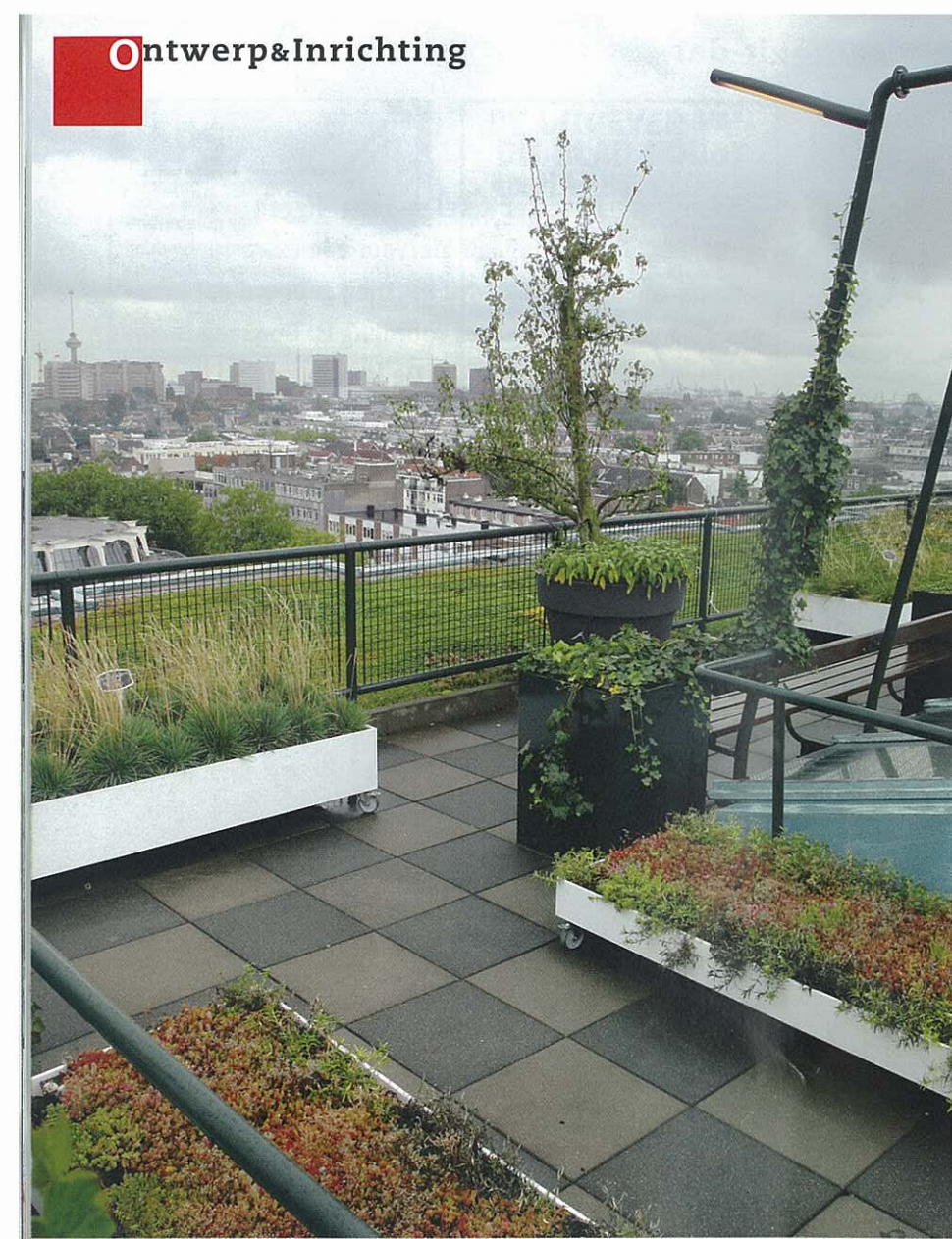
Het groene infodak laat zien dat zowel sedum als gras goed gedijt op het dak. Achter het hek het bestaande sedumdak; rechts een van de licht-groene lichtkoepels met bijbehorende verlichtingsstallage.
